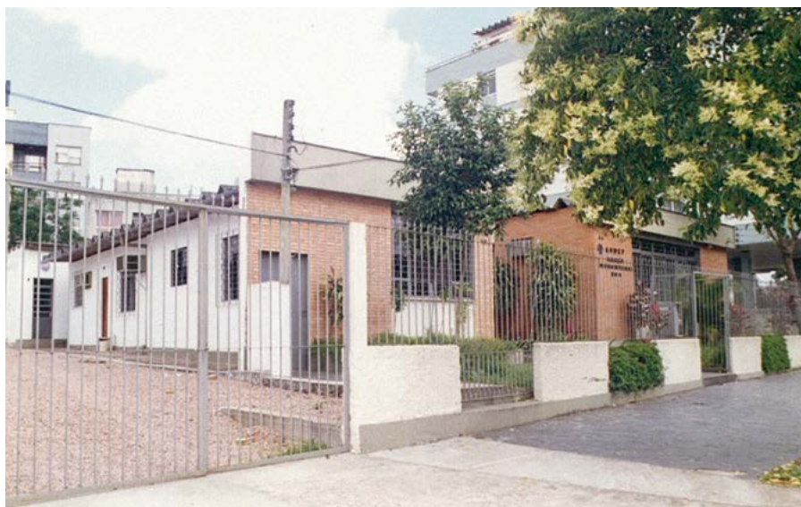
Primeira Sede da ASDEP, construída no mesmo terreno em que se localiza até hoje
